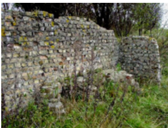
Afbeelding 54: Een bunker in de spoorwegberm (Bron: Heyde Etienne )
