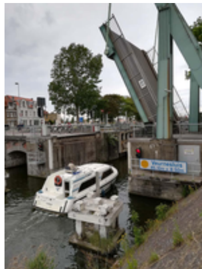
Afbeelding 27: De Veurnesluis en de uitwateringssluis (Bron: Heyde Etienne)
