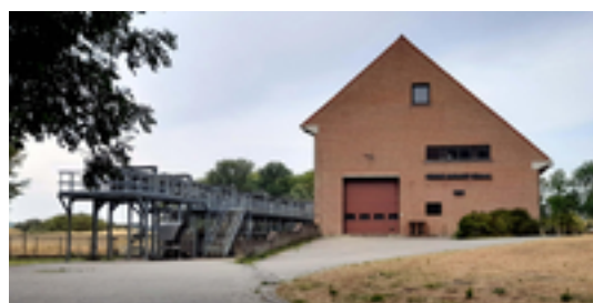
Afbeelding 52: Het pompgebouw 'Veurne-Ambacht' (Bron: Heyde Etienne)
