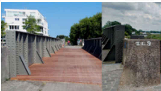
Afbeelding 57: De spoorwegbrug (Bron: Heyde Etienne )
